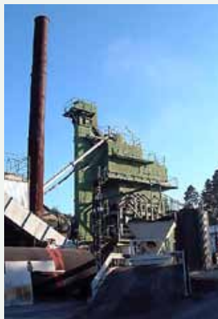
Asfaltproduksjon i hht CEN-standarder.
