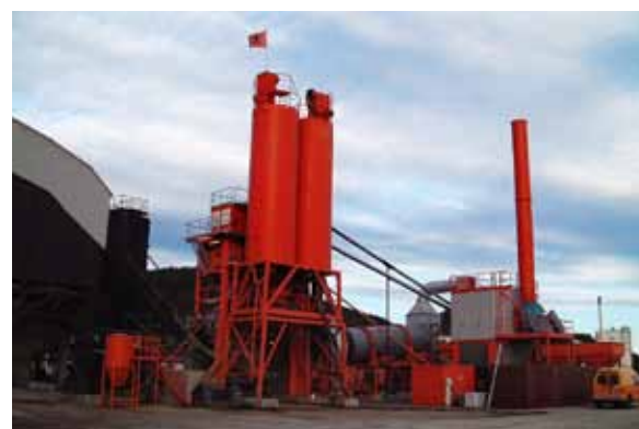
Asfaltfabrikk og miljømåling (støvutslipp).
