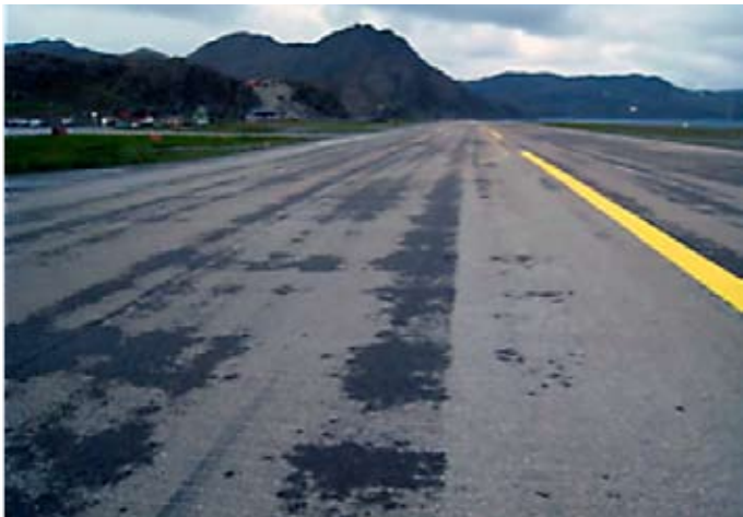
En utleggerbredde med kald masse, en OK.
